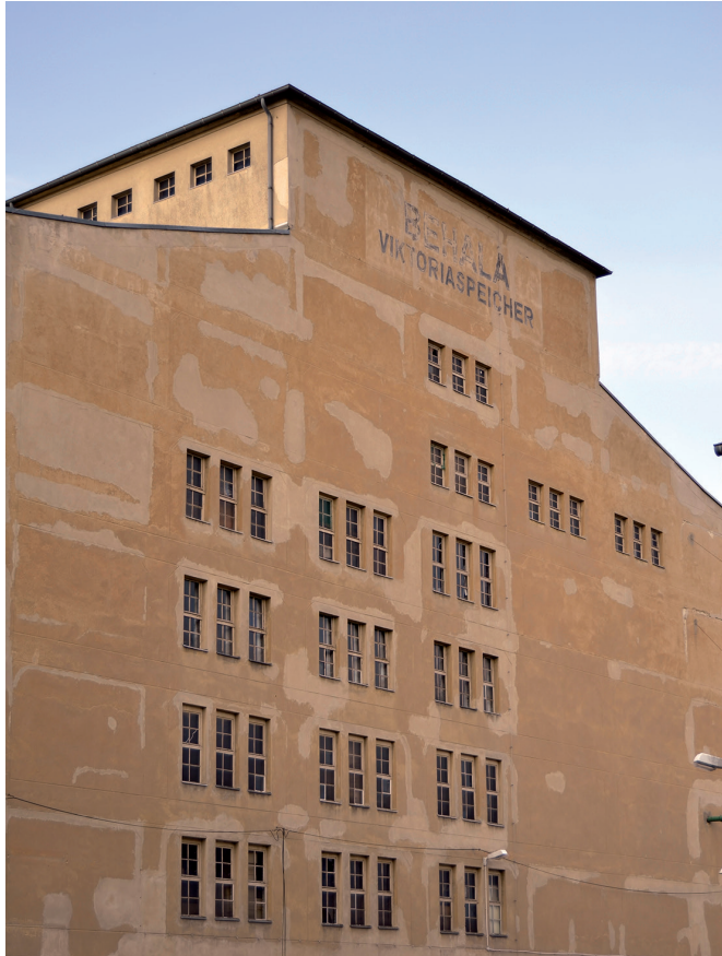
Viktoriaspeicher Köpenicker Straße, Kreuzberg
